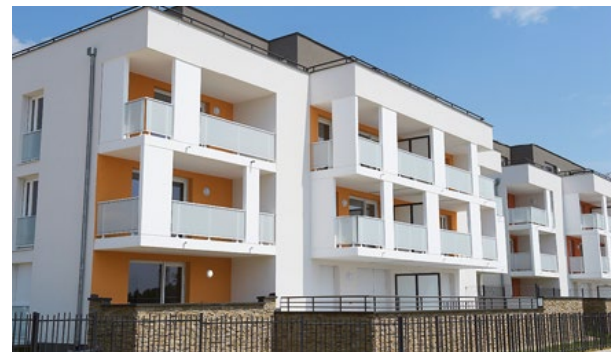
LOGEMENTS DU GRAND CHÊNE - BRUMATH
