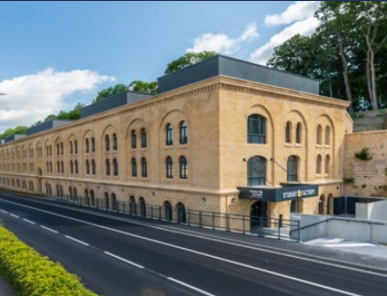
Réhabilitation de l'ancienne caserne en Résidence Student Factory, boulevard de Trèves
