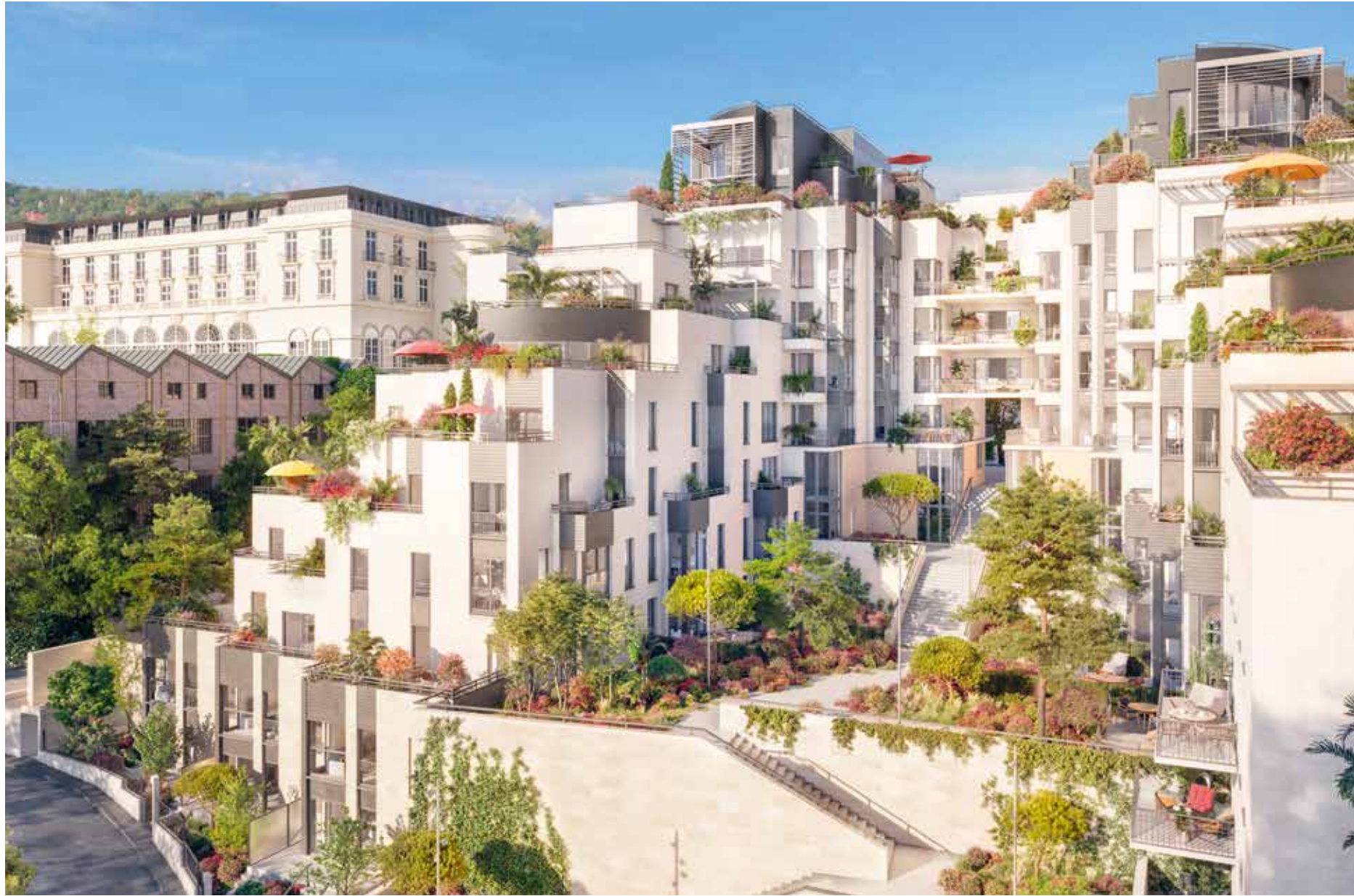
Vue drone sur le cœur d'îlot depuis le Chemin des Lacets
