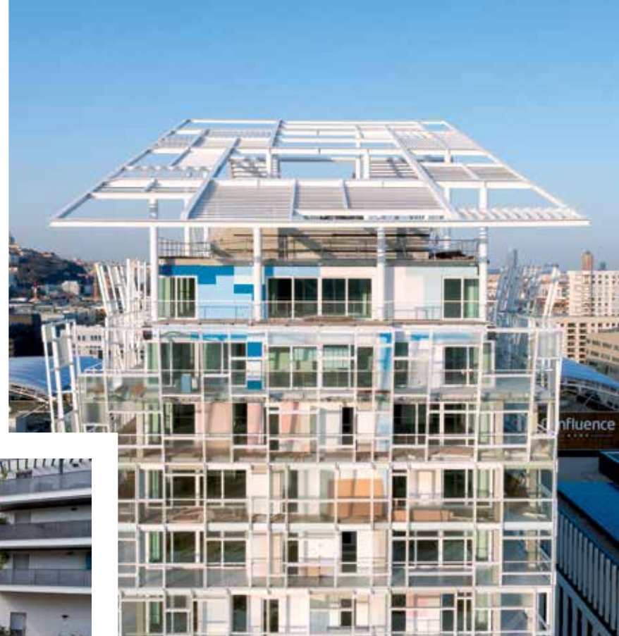
LOGEMENTS - Ycone - LYON 2*
