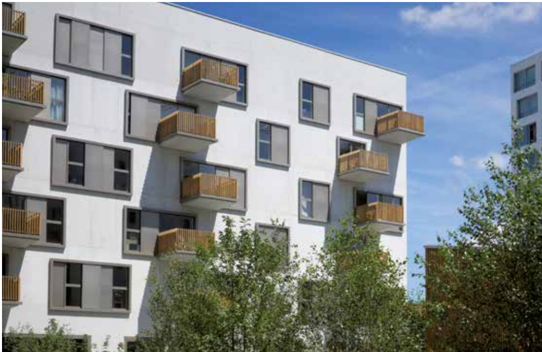
LOGEMENTS ET BUREAUX - Ilink - NANTES
