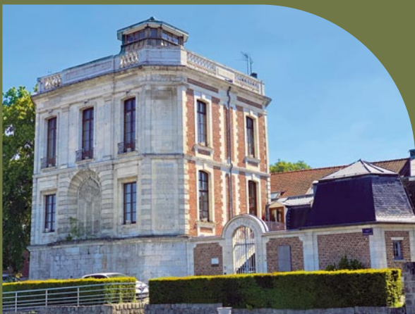
Le Château d'eau du port d'Aval édifié au XVIII ème siècle
