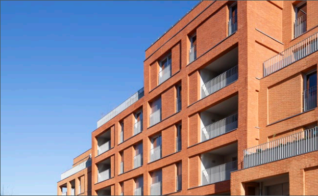
Résidence Live In Osmose - Toulouse
