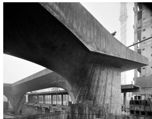
Piliers de la halle du grand matériel en béton coffré de forme paraboloïde hyperbolique
