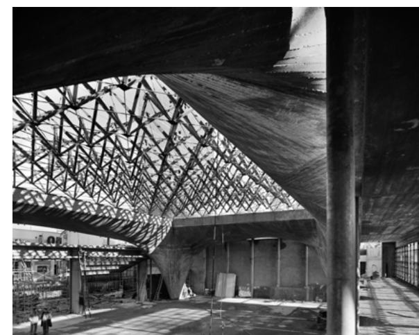
Halle du grand matériel, sa coursive et sa charpente métallique
