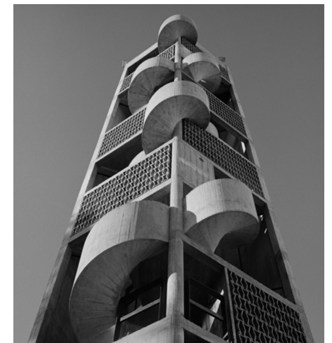
Tour de manœuvre et de séchage des tuyaux et son escalier hélicoïdal à effet rotatif
